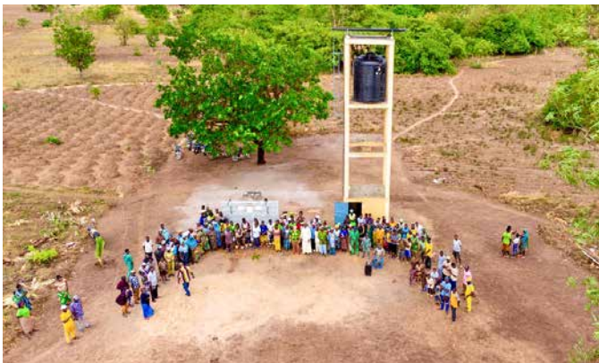
Il forage costruito nel villaggio di Fougou
