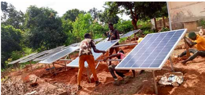
I lavori al Centro "Saint Joseph" di Wansoukou
