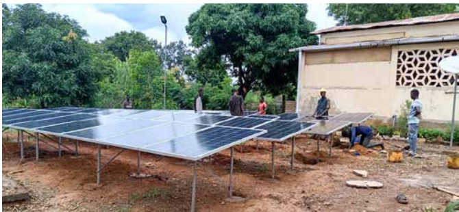
Die Arbeiten im Zentrum „Saint Joseph“ von Wansoukou
