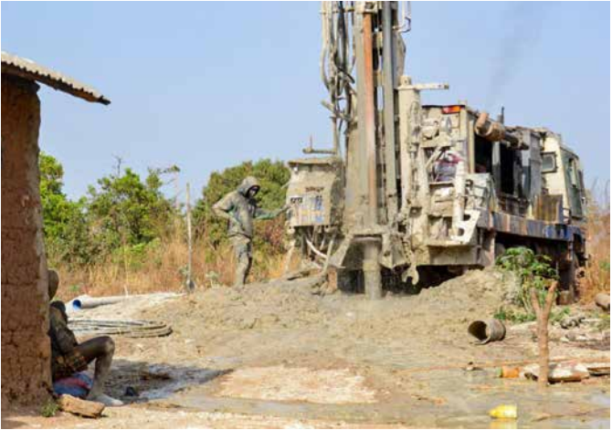
Aushub eines neuen Trinkwasserbrunnens
