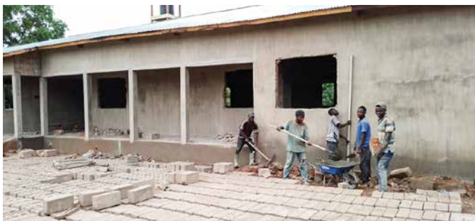
Il cantiere della nuova scuola primaria di Akpeho Dokpa
