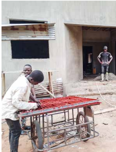
Die Baustelle der neuen Grundschule
