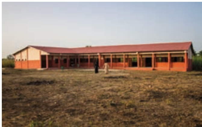
Das neue Gebäude der Grundschule „Maria Cristina Santuari“ von Yakabissi
