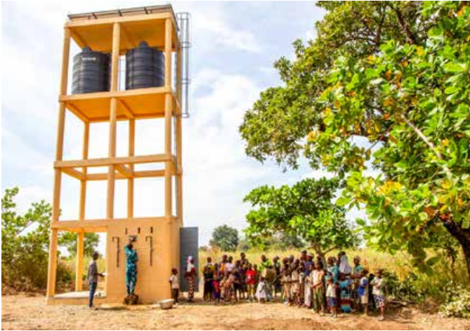
Einer der im letzten Jahr gebauten Trinkwasserbrunnen
